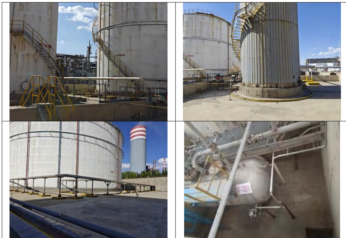
图 5.2-1 储罐类现场情况
